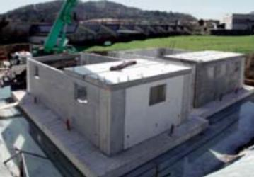
**Struttura in cemento armato antisismica** realizzata con pareti autoportanti interconnesse con sistemi a scomparsa sia in fondazione che tra pannelli e soletti.
